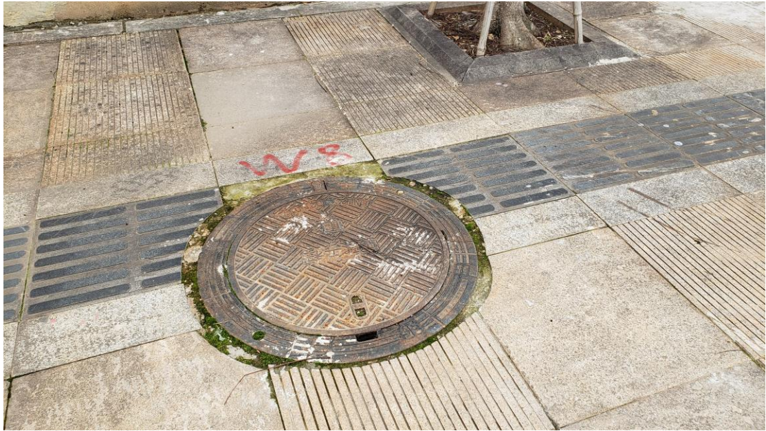
项目区排水设施（2020年2月）
