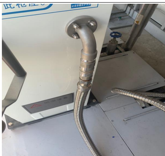
图3-4 拉断阀
