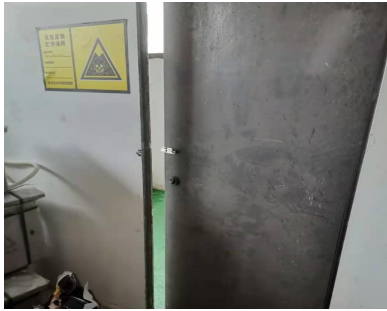
危险废物暂存间
