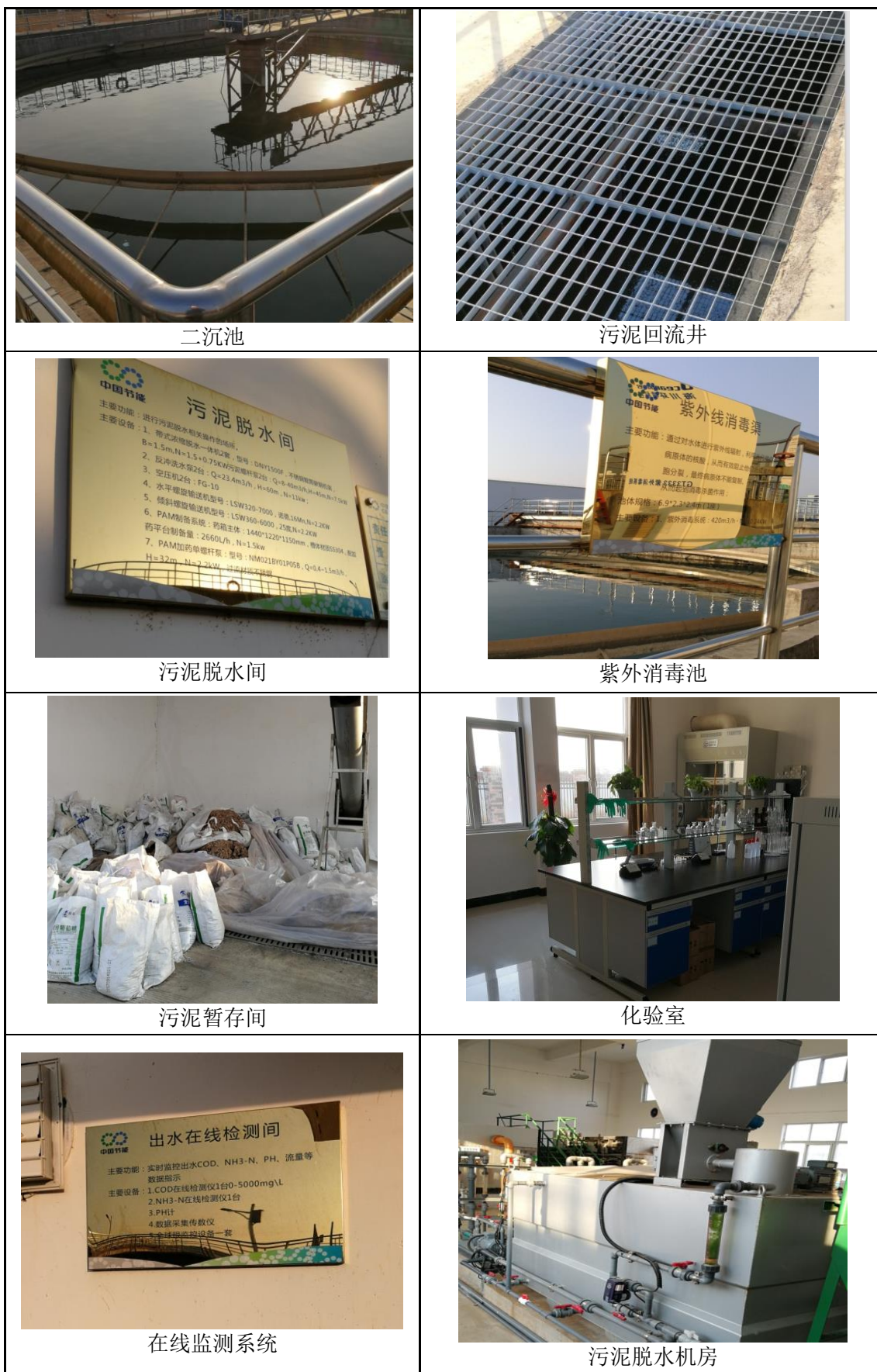
图 2.1-1 公司主要构筑物/设施照片
